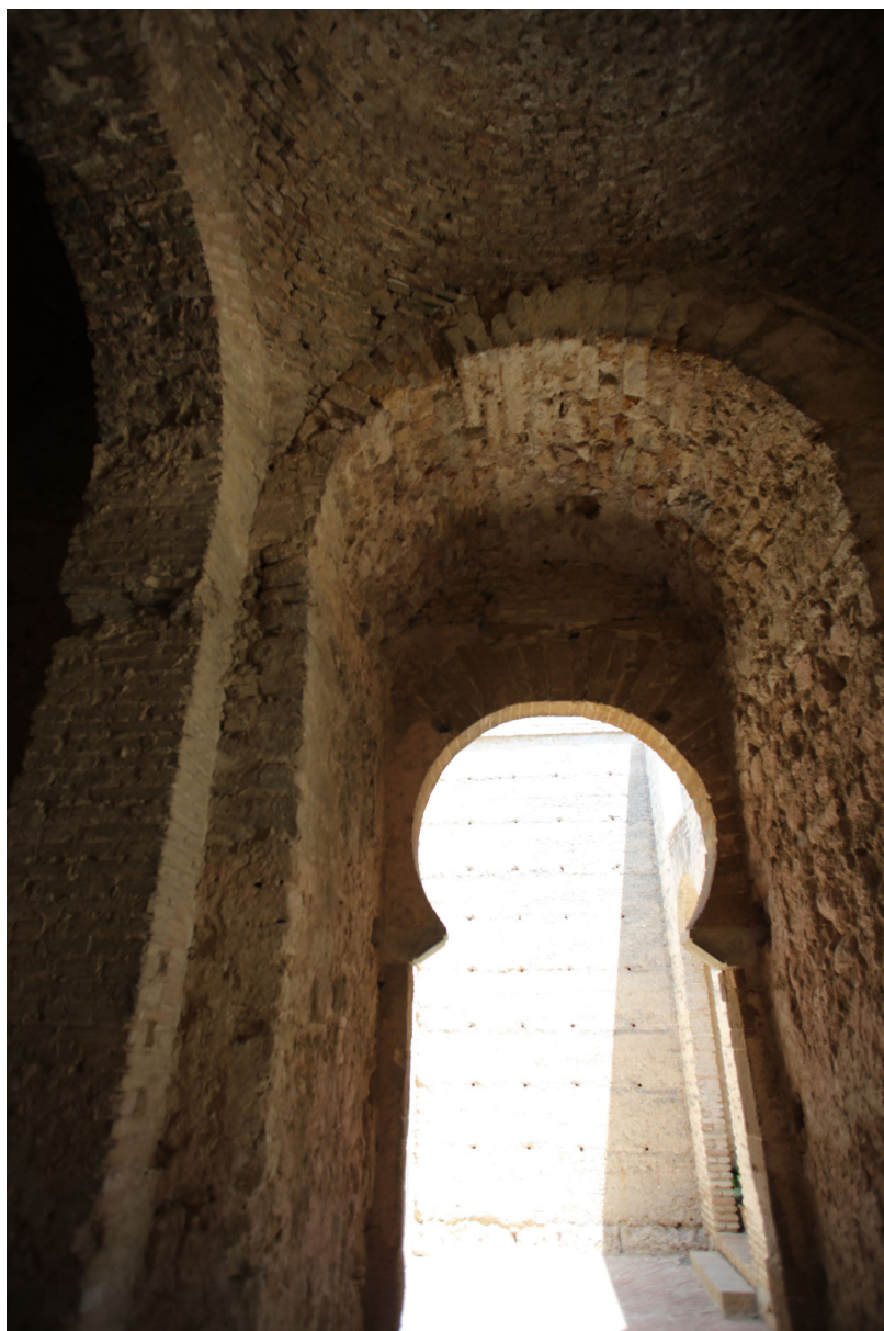
Fig. 5. Bóveda baída de la puerta de la Ciudad del Alcázar de Jerez de la Frontera , siglos XI-XII.
