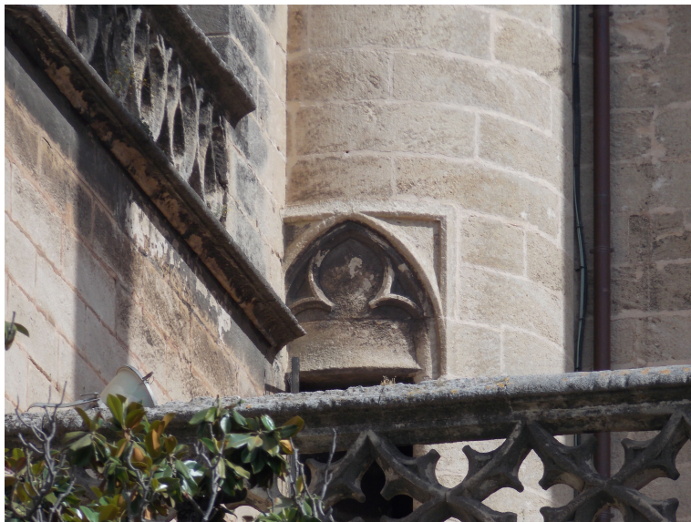
Fig. 4. Alfiz encuadrando la puerta de salida a las cubiertas de la capilla de San Laureano de la catedral de Sevilla. Fuente: autor (2023).
