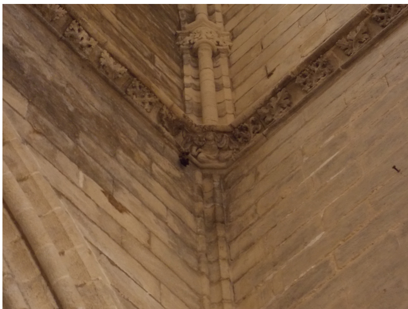
Fig. 3. Ménsula volada recogiendo un baquetón entre la capilla de San Laureano y la nave de San Roque de la catedral de Sevilla. Fuente: autor (2023).
