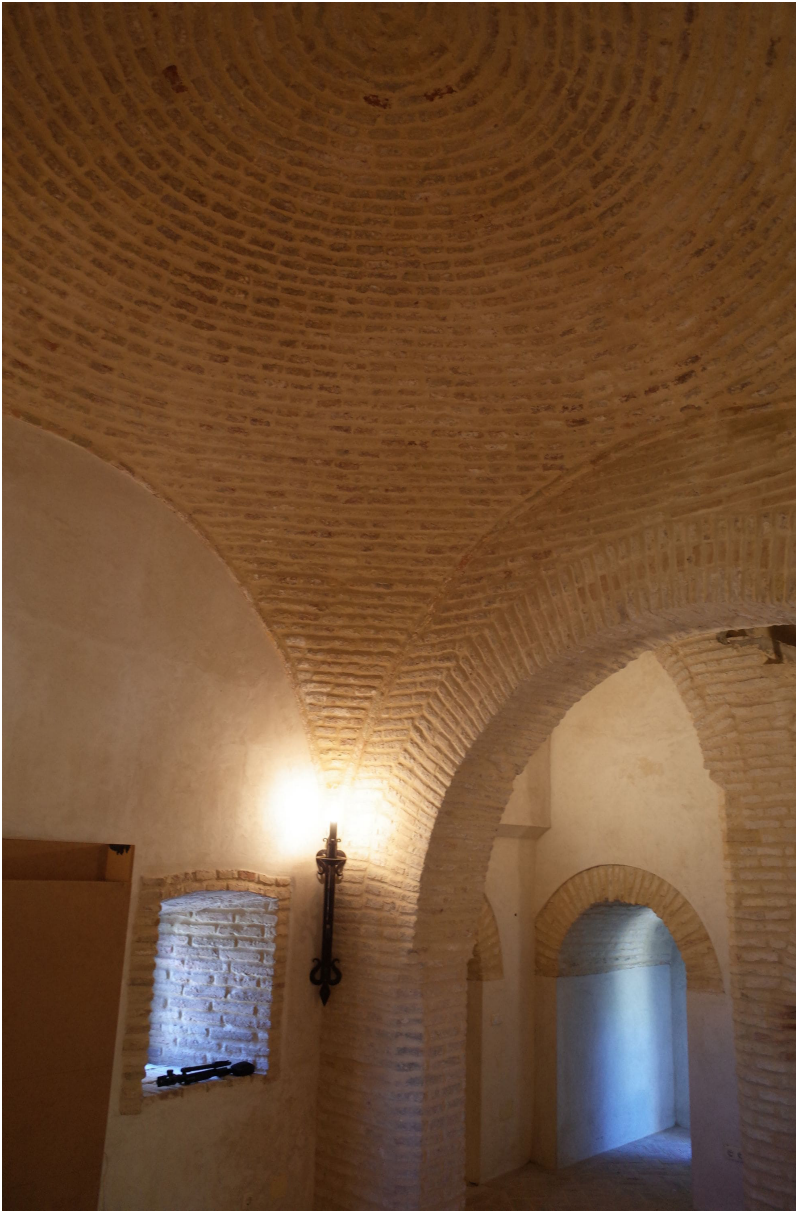
Fig. 6. Bóveda baida de la torre del Homenaje del Alcázar de Jerez de la Frontena, 1471-1477.
