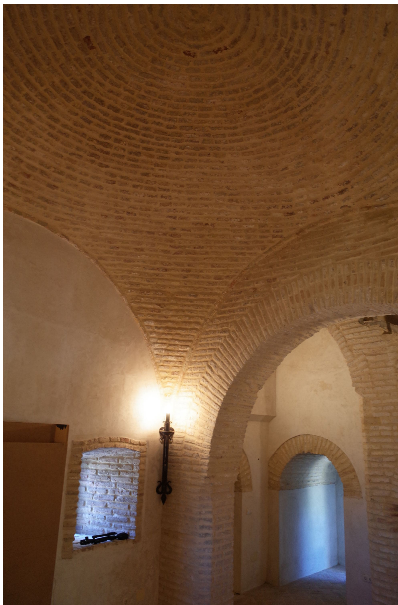
Fig. 6. Bóveda baída de la torre del Homenaje del Alcázar de Jerez de la Frontera, 1471-1477.
