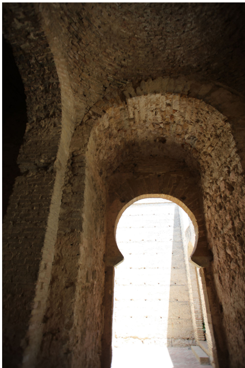
Fig. 5. Bóveda baída de la puerta de la Ciudad del Alcázar de Jerez de la Frontera , siglos XI-XII. Fuente: Almagro Gorbea, ATARAL , inventario: 372_i07.
